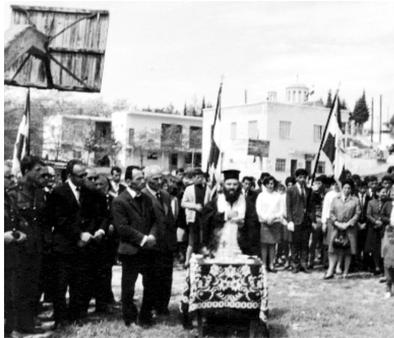
Αγιασμός για την θεμελίωση του κτηρίου του Συλλόγου
